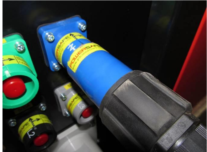
Figuur 24. Het aansluiten van de vermogensconnectoren.
