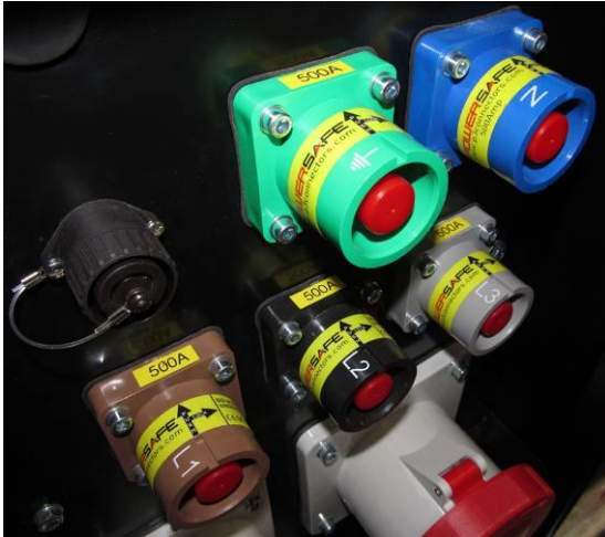
Figuur 23. Elke connector heeft zijn eigen kleur. L1/L2/L3/N/PE zijn gemarkeerd.
